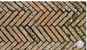
AȘA DA: Materialele locale naturale, precum tocătura de lemn, felile de trunchiuri și cărămida plină confecționată manual, pot fi folosite pentru pavaj, chiar dacă nu au fost folosite în acest scop în mod tradițional.
