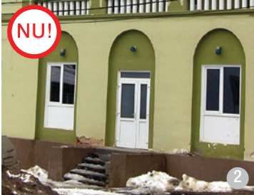
AȘA NU: Necesitatea închiderii porticului nu justifică umplerea golurilor inițiale și montarea unei tâmplării albe din PVC, în poziții aleatorii, cu dimensiuni aleatorii.
