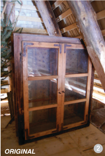
AȘA DA: Pentru restaurarea bisericii din lemn, a fost păstrată ca model o fereastră originală, după care au fost realizate ferestrele noi, din același material și în tehnici similare.
