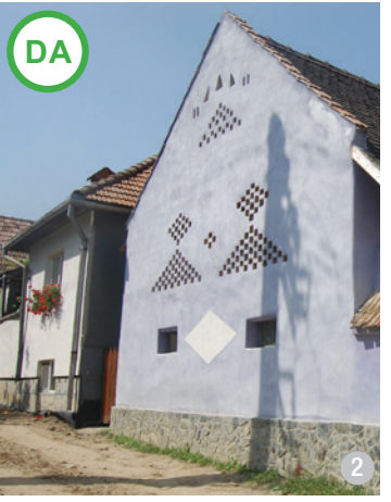
AȘA DA: Din rațiuni legate de configurația reliefului și a terenului, șura este, în mod excepțional, așezată la stradă, motiv pentru care peretele din zidărie a fost tencuit. Se recomandă realizarea golurilor cu forme rezultate exclusiv din poziționarea decalată a cărămizilor (goluri dreptunghiulare). Dimensiunile și proporțiile construcției, precum și culoarea tencuielii, se încadrează în specificul local.
