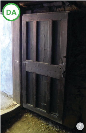
Ușă de intrare în pivnița gospodăriei din sat, din lemn bălăuit sau tratat cu ulei ars
