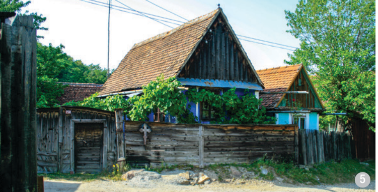
Soluție tradițională de rezolvare a împrejmuirii și a porților din lemn. Aici, doar porțița are acoperiș propriu; în alte situații, și poarta, și gardul au acoperișuri.
