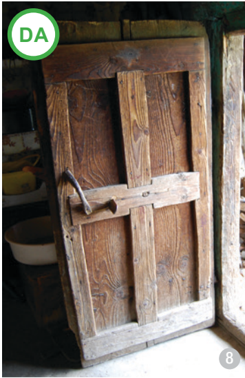
Ușă de intrare în colibă, din lemn masiv natur, cu elemente de rigidizare în formă de cruce. Piese mecanice sunt realizate din lemn.
