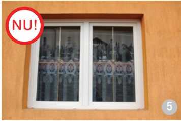
AȘA NU: Tâmplărie din PVC, albă, cu baghete și ornamente auriu. Nu fac parte din valorile tradiționale arhitecturale plasticul și materialele lucioase.
