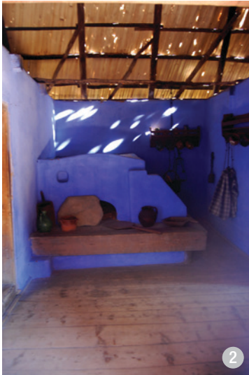
Tinda casei era deschisă spre pod. Aici se gătea, iar fumul ieșea lent printre elementele acoperișului lipsit de coșuri de fum sau lucarne, pentru a conserva produsele din carne păstrate pentru iarnă și pentru a evita împozitarea.
