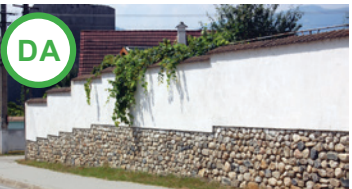
AȘA DA: Împrejmuire cu soclu din zidărie de piatră de râu, aparentă, și zidărie de cărămidă tencuită, acoperită cu țiglă solzi
