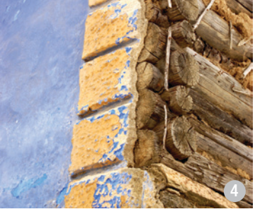
Tencuială de var aplicată pe cerchia de lemn, pe perete din bărne etanșate cu pământ galben și pleavă de cereale
