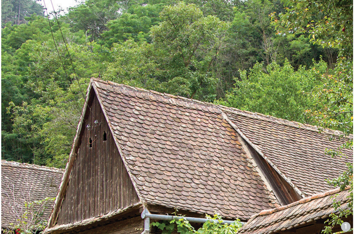
Casă din bârne de lemn netencuită, cu acoperiș din țigla solzi și timpan din scânduri. Împrejmuirea are acoperiș din țigla. Probabil că învelitoarea inițială era din șindrilă.
