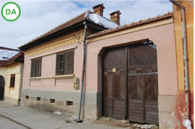
AȘA DA: Poartă cu porțiță inclusă, realizate din lemn masiv băițuit, cu decorații specifice. Obloanele ferestrelor sunt realizate din același material și tratate identic.
