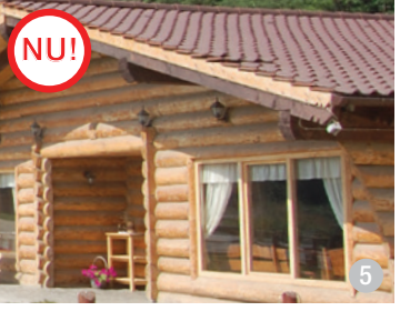
AȘA NU: Pereții realizați din bușteni necântuiți sau cu dimensiuni mai mari de 15 m nu sunt specifici arhitecturii tradiționale.
