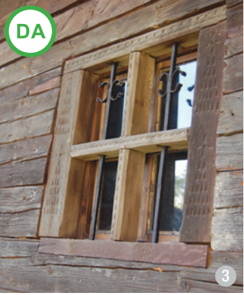
Fereastră tradițională din lemn natur, cu ancadrament din lemn decorat prin incizări în daltă. Tijele din fier forjat au rol de protecție suplimentară la intruziune.
