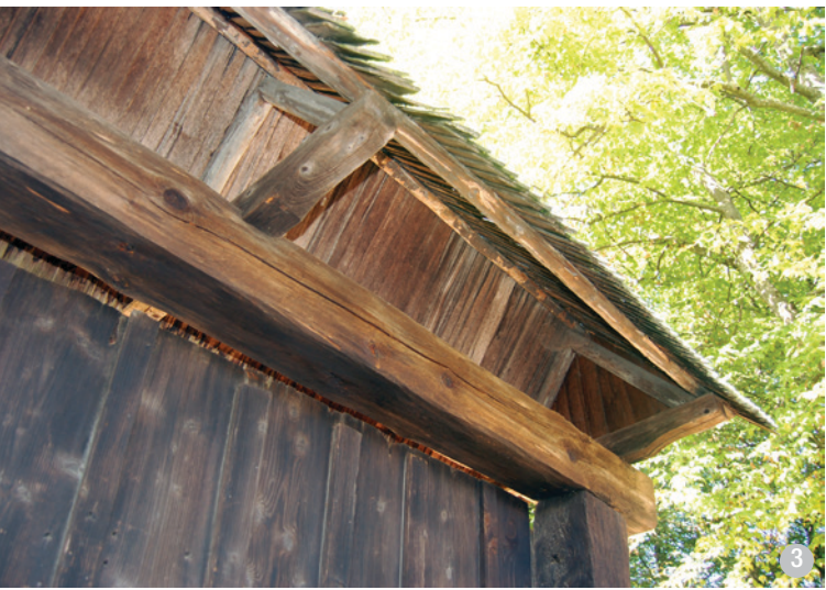
Acoperiș de poartă din structură de lemn, cu învelitoare din șindrilă
