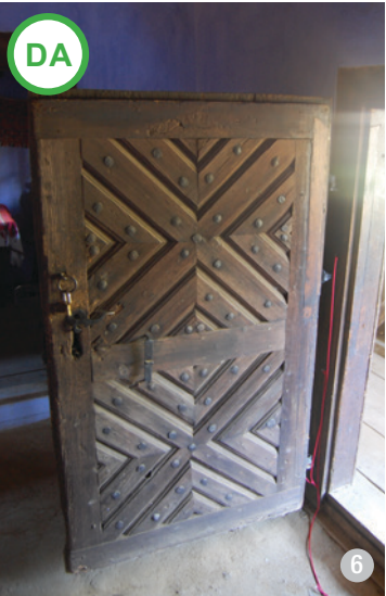
Ușă principală de intrare în casa gospodăriei din sat, realizată din lemn masiv, cu feronerie și decorații din fier forjat
