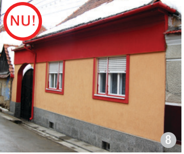
AȘA NU: Culori stridente pe fațada dinspre stradă, care accentuează elementele nespecifice plasticii arhitecturale tradiționale
