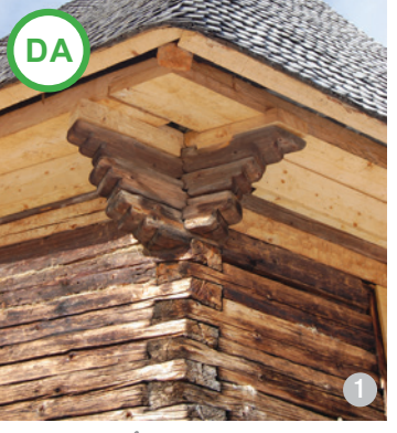
AȘA DA: Îmbinări de colț la o construcție din bărne de lemn reabilitată. Materialul nou este vizibil și completează armonios piesele vechi recuperate.
