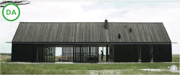
AȘA DA: Nevoia de lumină naturală este satisfăcută prin ferestrele din planul acoperișului și prin vitrajele ample, mascate de riflaj din baghete de lemn, cu rol de protecție solară.
