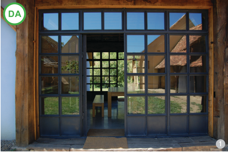
AȘA DA: Transformarea șurii în spațiu de locuit a creat nevoia de închidere cu tâmplărie a ceea ce în mod tradițional era un spațiu de trecere, închis cu porți din scânduri. Tâmplăria simplă, din oțel vopsit, cu ochiuri pătrate egale, dispuse ordonat pe cele două direcții, oferă protecție la vânt, păstrând transparența și senzația de spațiu intermediar, specifică șurii.
