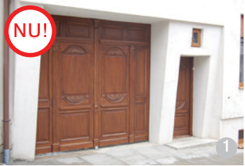
AȘA NU: Poartă din lemn masiv cu decorații aparținând altor timpuri și locuri geografice. Lacurile și băițurile folosite au un luciu excesiv și o nuanță roșiatică nespecifică locului. Volumetria ancadramentului este, de asemenea, străină de stilul tradițional.
