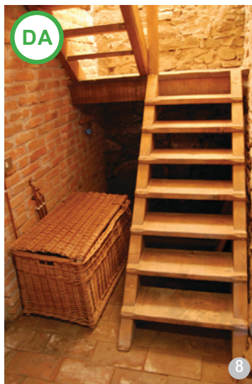
AȘA DA: Scară din lemn pentru acces în pivniță. Pardoseala pivniței este realizată din cărămidă plină confecționată manual de meșteri locali, așezată pe pat de nisip. Pereții din zidărie de piatră și de cărămidă sunt lăsați la vedere.
