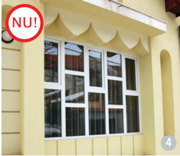
AȘA NU: Tâmplărie din PVC, albă, cu o împărțire a ochiurilor de geam străină de specificul locului. Modelul ancadramentului este preluat din alte zone geografice.
