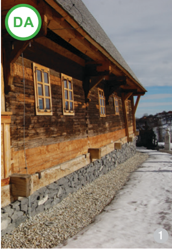
ASA DA: Soclul și fundațiile construcției sunt realizate din piatră de țanc, iar pe o fâșie perimetrală de 30 – 60 cm s-a așezat pietriș, pentru drenarea apei departe de fundații.
