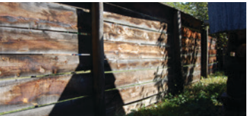
AȘA DA: Garduri din lemn: împrejmuiri spre stradă și laterale
