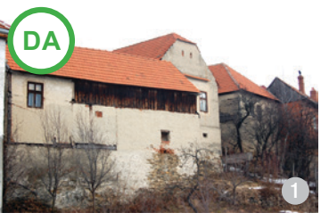
AȘA DA: Fațade secundare spre funduri de lot, tencuite cu mortar pe bază de var cu nisip, în culoare naturală
