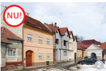
AȘA NU: Construcțiile au forme străine de specificul tradițional și fac notă discordantă cu imobilele vecine.
