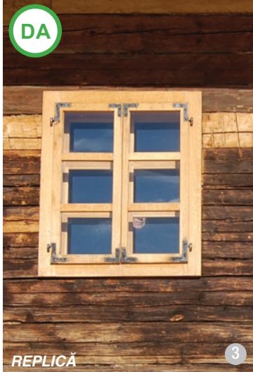
AȘA DA: Pentru restaurarea bisericii din lemn, a fost păstrată ca model o fereastră originală, după care au fost realizate ferestrele noi, din același material și în tehnici similare.
