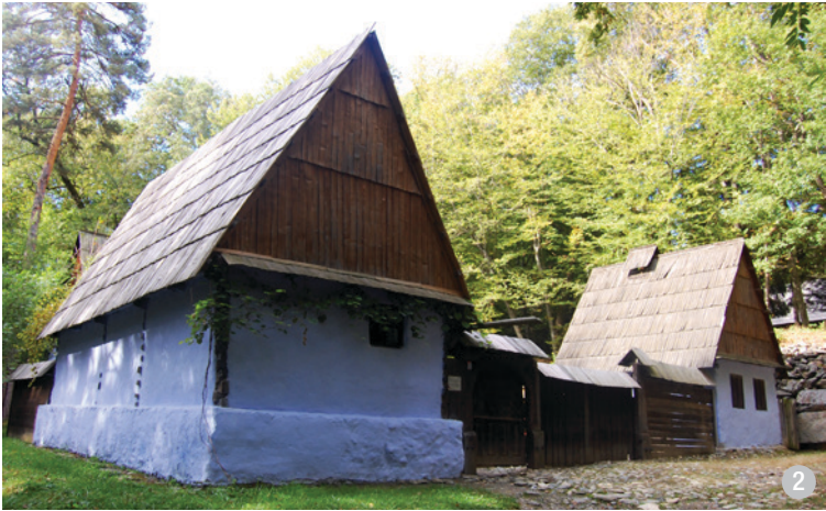
Casă cu acoperiș învelit cu șindriță
