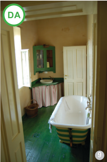
AȘA DA: Spațiul băii a fost creat prin micșorarea unei camere, iar tâmplăria nouă a fost realizată din aceleași materiale, de un meșter local. Pardoseala este dușumea vopsită și lăcuită cu soluții de mare rezistență.
