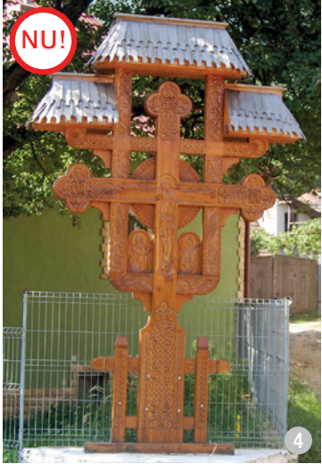
ASA NU: Troiță din lemn cu învelitoare din tablă care imită șita. Nu se recomandă folosirea imitațiilor, ci a materialelor tradiționale locale.
