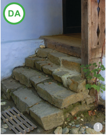
AȘA DA: Pavajul era realizat, în mod tradițional, din piatră de râu sau lespezi de piatră. Pietrișul ciuruit poate fi folosit pe conturul construcției pentru drenarea apelor meteorice.
