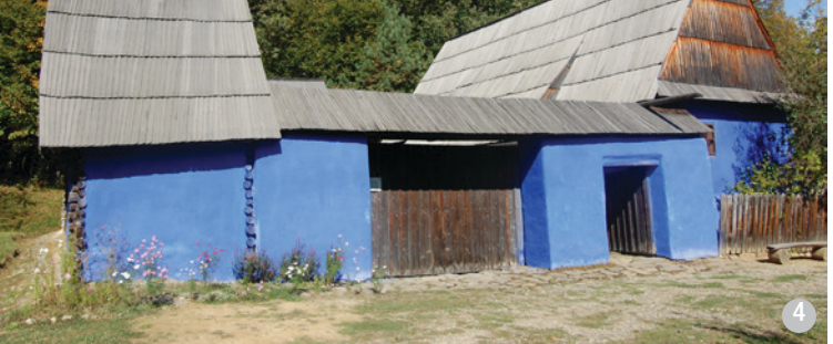
Soluție tradițională de poartă și porțiță la o gospodărie cu ocol întărit din zidărie de cărămidă tencuită
