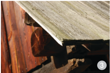
Detaliu de învelitoare din șindrilă
