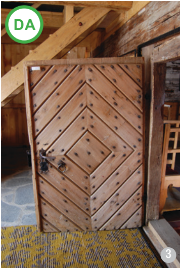
AȘA DA: Ușă reconstituită din același material, foarte probabil, după modelul ușii originale.
