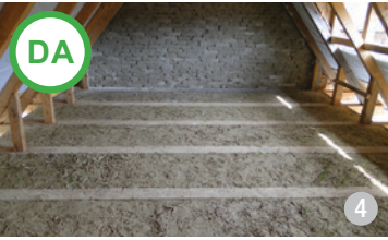
AȘA DA: Se recomandă izolarea termică a podurilor cu materiale ecologice.
