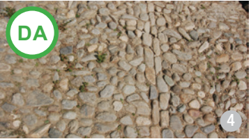
AȘA DA: Pavajul era realizat, în mod tradițional, din piatră de râu sau lespezi de piatră. Pietrișul ciuruit poate fi folosit pe conturul construcției pentru drenarea apelor meteorice.
