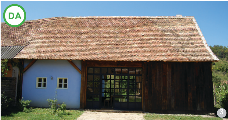
AȘA DA: Șura a fost transformată în spațiu de pregătire și servire a mesei, păstrând caracterul de zonă de trecere – cu privirea – a zonei de mijloc, respectiv închiderile opace laterale: una cu scânduri pentru vechea depozitare, cealaltă, cu zidărie tencuită, corespunzând vechiului grajd.
