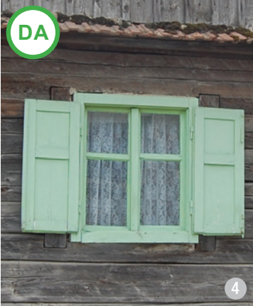
Fereastră tradițională din lemn vopsit, cu ancadrament simplu și obloane din tăblii din lemn vopsit
