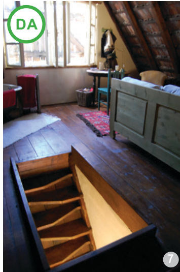
AȘA DA: Scară din lemn pentru acces în dormitorul amenajat în volumul podului existent. Fereastra se deschide amplu spre grădina din spate și este mascată de obloane din scânduri, la fel ca restul timpanului.
