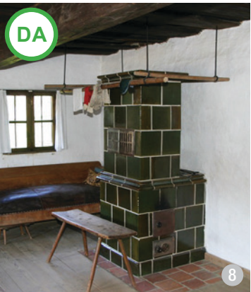
AȘA DA: Sobe de teracotă presupun un mod de viață în jurul casei, pentru a putea fi alimentate constant și a menține căldura. Cele pe gaz pot primi termostat.
