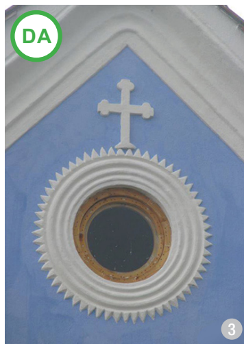
ASA DA: Atunci când nu se distruge vreo evidență istorică, se pot amplasa goluri în elementele geometrice ale fațadelor, întărindu-le efectul. (Șona, jud. Brașov)
