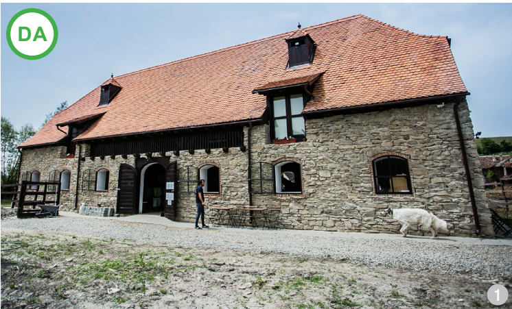
AȘA DA: Zid mixt din piatră de gresie, cărămidă și elemente din beton, care combină tehnica tradițională cu cea contemporană, pentru a corespunde cerințelor de stabilitate etc. – proiect realizat cu finanțare europeană. (Apoș, jud. Sibiu)
