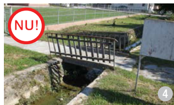
ASA NU: Podeț din beton și metal
