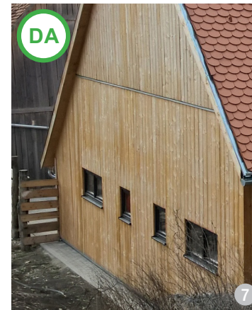
AȘA DA: Alegerea sistemului de construcție cu finisaje din lemn permite dimensionarea streșinii la valoarea ei maximă: 25 cm. (Roadeș, jud. Brașov)
