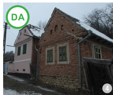
Construcție cu fundație de piatră și pereți din cărămidă (Ghijasa de Jos, jud. Sibiu)
