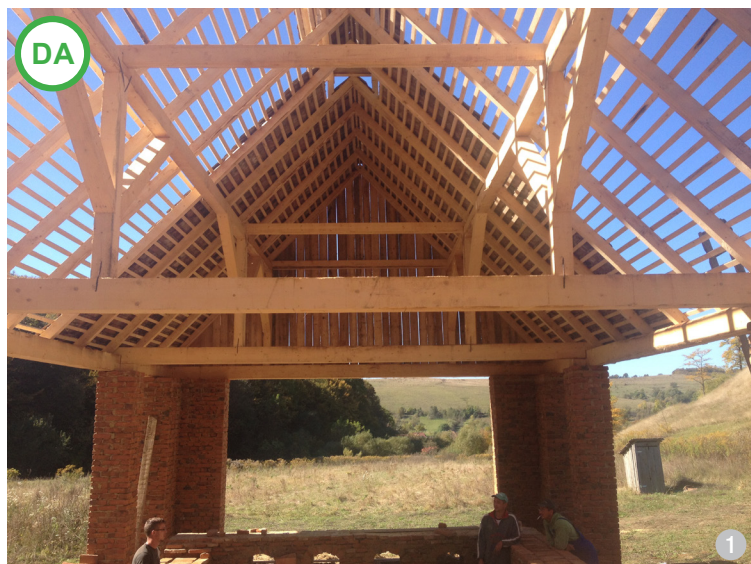
AȘA DA: Șarpantă realizată cu „scaun” specific construcțiilor cu deschidere mare (Apoș, jud. Sibiu)
