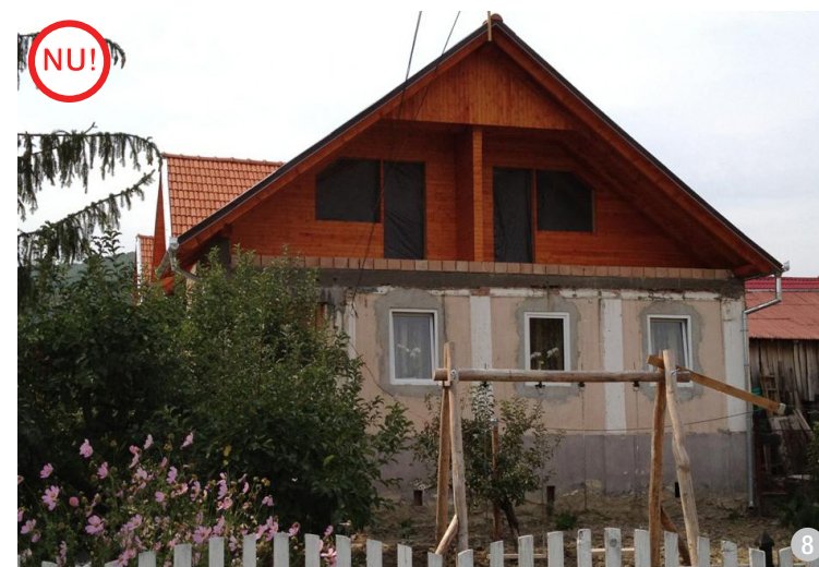
ASA NU: Nu se acceptă amplasarea logiei și a balconului către stradă și cu atât mai puțin distrugerea frontonului și a decorațiilor pentru realizarea intervenției. (Șaeș, jud. Mureș)
