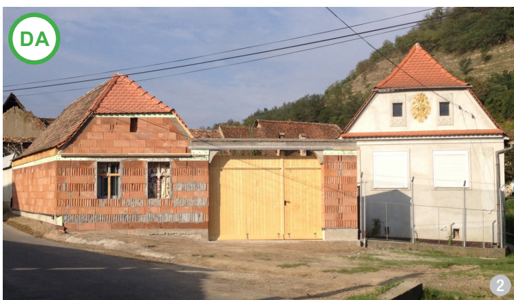
AȘA DA: Clădirea nouă, realizată din cărămidă cu goluri mari și beton, arată că anumite materiale noi pot fi puse în operă, în logica lor, într-un mod care să țină cont de volumetria specific locală. (Richiș, jud. Sibiu)
