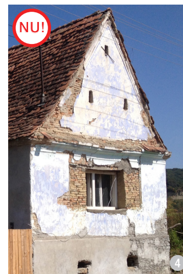
ASA NU: Caz frecvent de modificare inadecvată a golurilor ferestrelor de la fațadă: prin amenajarea unui gol în axa frontonului, se slăbește stabilitatea acestuia, riscând să apară fisuri. (Daia, jud. Mureș)
