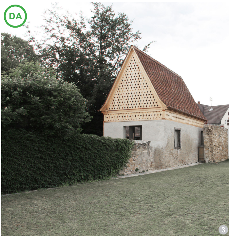
ASA DA: Intervenție de reconstruire a unui acoperiș și înălțare a construcției. Intervenția contemporană este vizibilă prin folosirea unui model de traforaj aparte, iar forma tradițională a acoperișului este respectată. (Buggingen, Germania)
