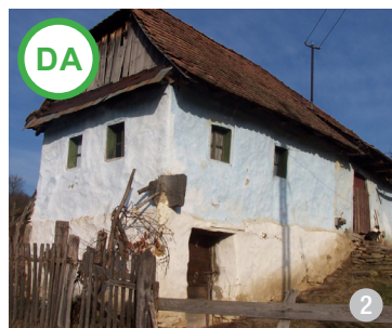
Casă românească cu pereți de lemn așezați pe un demisol construit din piatră. (Săsăuș, jud. Sibiu)
