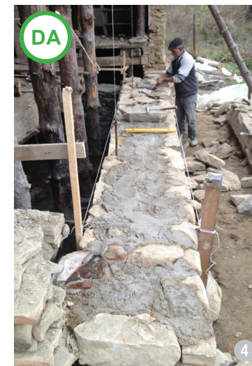
Folosirea pietrei pentru zidurile și fundațiile construcțiilor noi este optimă în zonele cu umiditate mare. (Daia, jud. Mureș)
