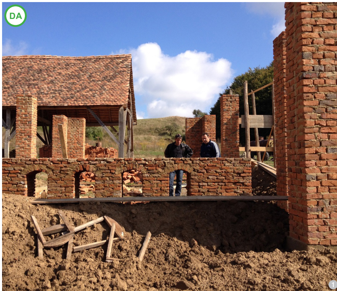
AȘA DA: Construcție nouă cu pereți și stâlpi din cărămidă și beton: cărămida tradițională, prin dimensiunile ei mici, se adaptează ușor la orice configurație planimetrică, chiar și în detaliu. (Apoș, jud. Sibiu)
